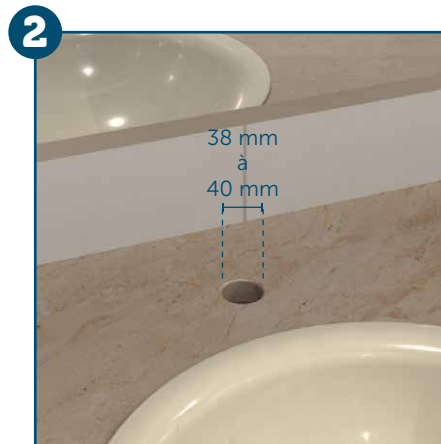
2 O diâmetro do furo da mesa da pia poderá variar de 38 mm à 40 mm. El diámetro del orificio de la mesa del lavabo podrá ser entre 38 mm a 40 mm.
