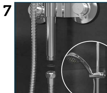
Por fim, conecte um dos terminais da ligação flexível na barra deslizante. Faça o mesmo procedimento para a ducha/chuveiro. Após isso, abra o registro geral.
