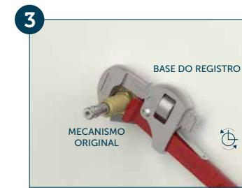
Com uma chave de cano (grifo), retire o mecanismo do registro defeituoso da parede.
