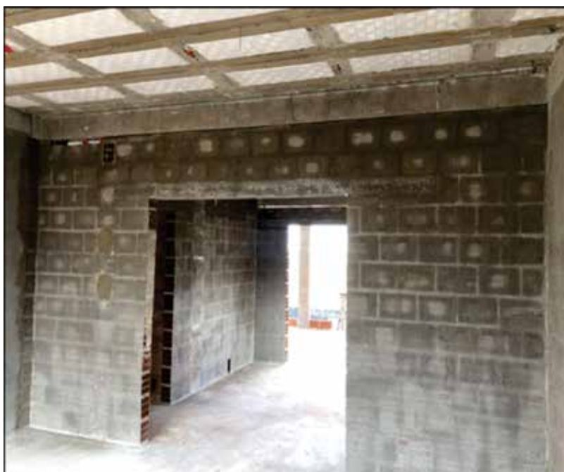
f igura 5 - Parede aplicado o chapisco em alvenaria cerâmica.
