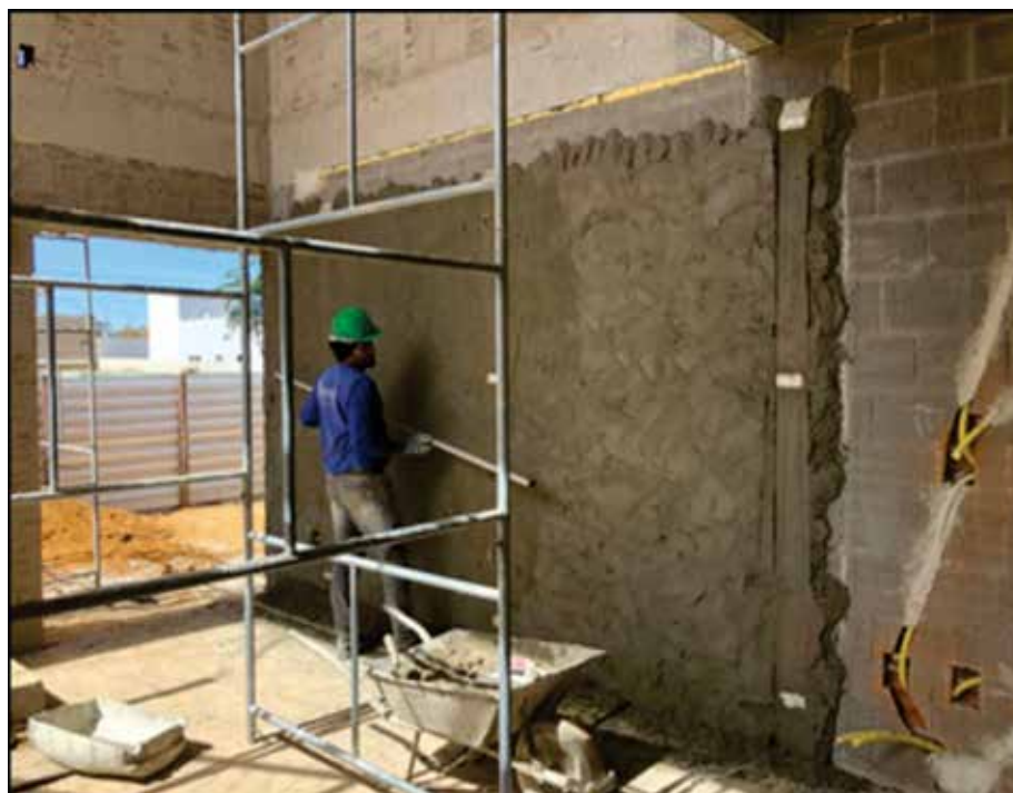
f igura 4 - Reboco feito com massa e uso mestras como guia.
