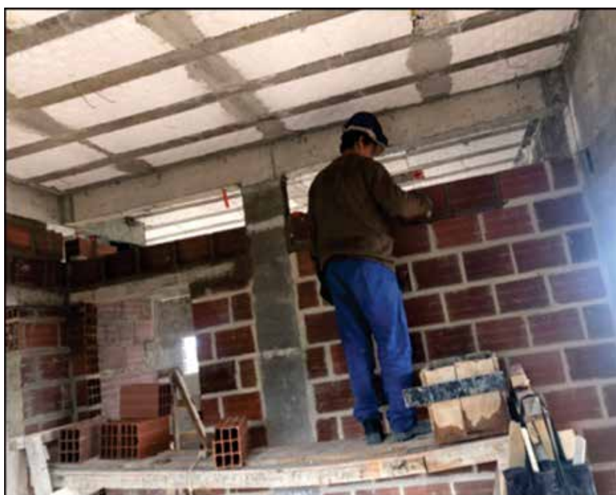
figura 3 - Lavamento de alvenaria em bloco cerâmico com dimensão de 09x19x29 cm.
