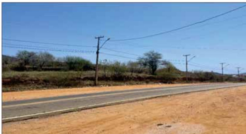
figura 01 – Disposição Irregular de resíduos da construção civil
