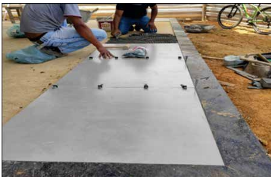
figura 6 - Revestimento sendo aplicado sobre a argamassa.
