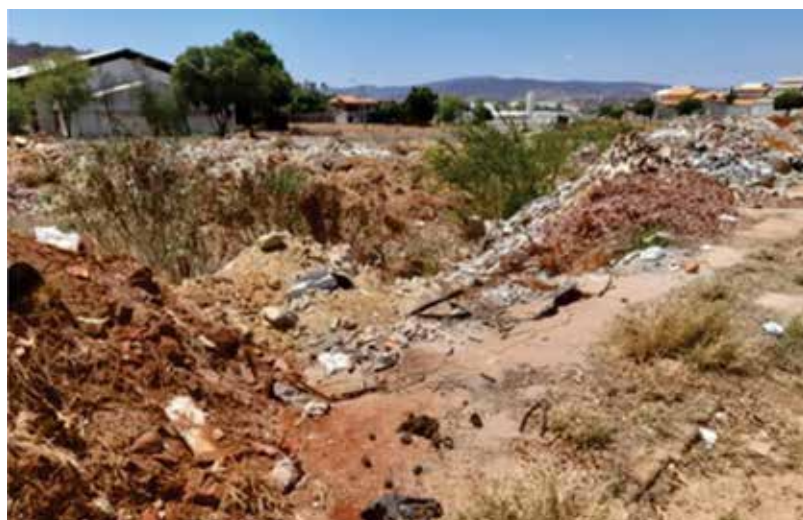
figura 03 – Disposição Irregular de resíduos da construção civil.
