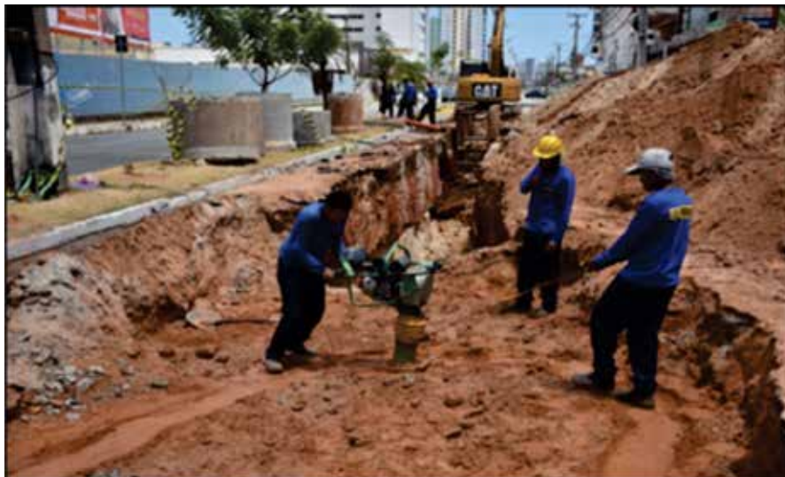
figura 7 - Construção de Rede Coletora no Estado do Maranhão
