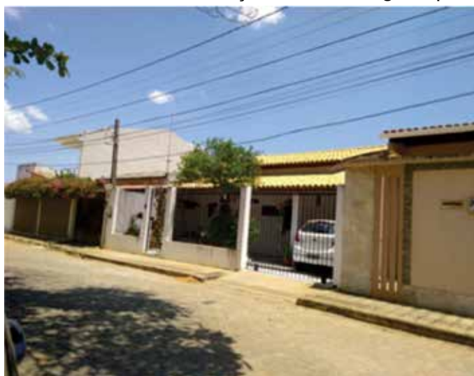
figura 4 – Telhados com lançamentos de águas para rua
