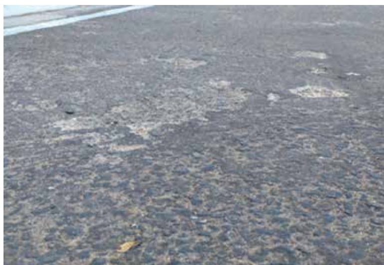
figura 1 – Superfície Gasta
