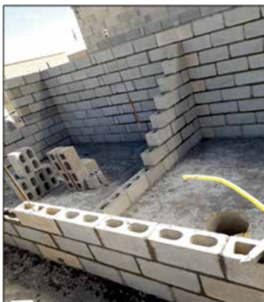
Figura 1 – Alvenaria estrutural de concreto armado.
