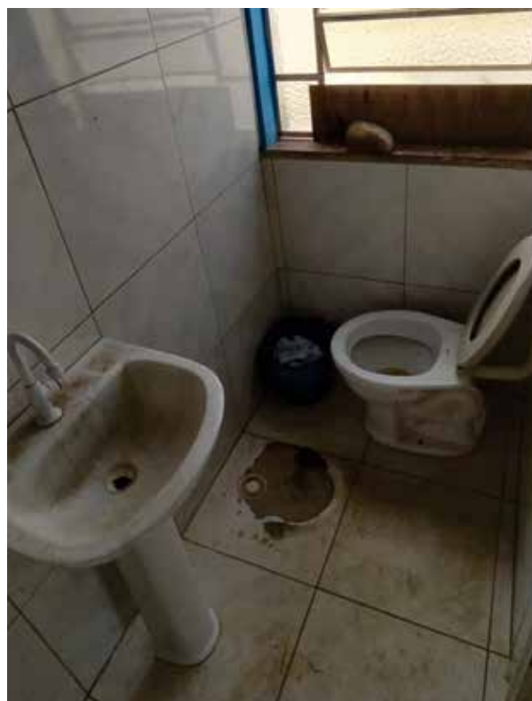
Figura 16 - Banheiro da Secretaria de Obras
