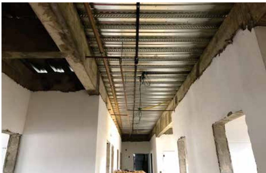
Figura 3 – Fôrma metálica utilizada para acabamento de forro
