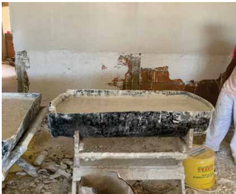
Figura 02 – Aplicação “mestrada” da massa de gesso.
