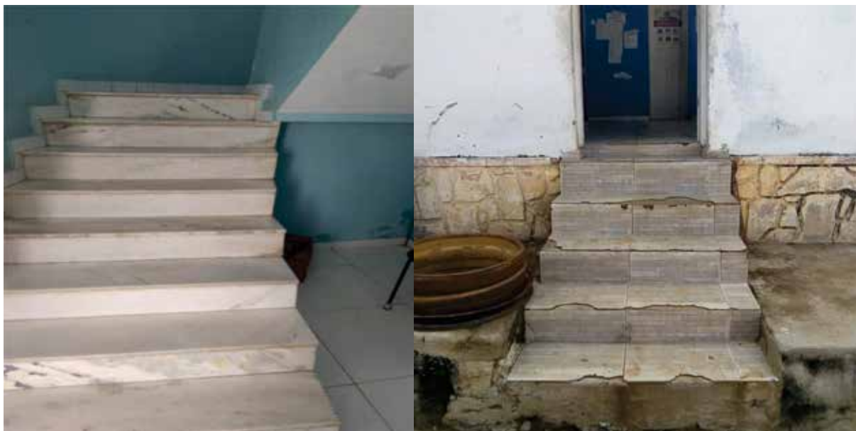
Figura 15 – Escadas de acesso (Formatado)
