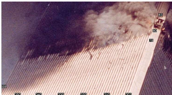
Columnas exteriores del WTC 2 combándose hacia dentro a lo largo de la cara este entre las plantas 77 y 83 a las 9:58:55 A. M. (NIST NCSTAR 1-6, página 178, Figura 6-21).
