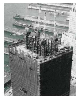
El WTC 1 durante la construcción.
