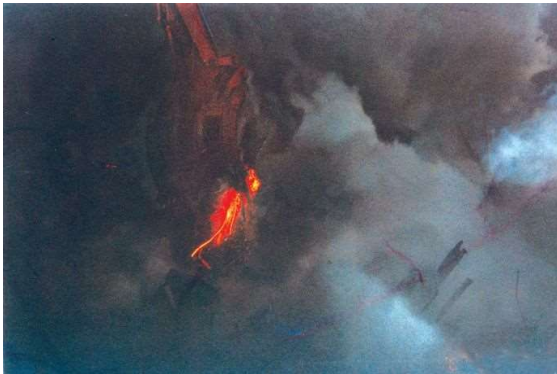
Esta fotografía, tomada por Frank Silecchia el 27 de septiembre de 2001, muestra una pieza de metal desenterrada que es de color salmón a amarillo, indicando temperaturas de 845°C (1550°F) a 1040°C (1900°F).
