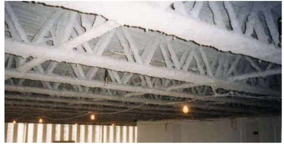
Una fotografía de las celosías del WTC con ignífugos..
