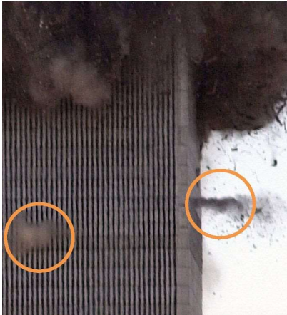
Ráfagas de escombros de alta velocidad, o "buscapiés", siendo eyectadas desde fuentes puntuales en el WTC 2 y WTC 2, tantas como 20 a 30 plantas debajo del frente de colapso.
