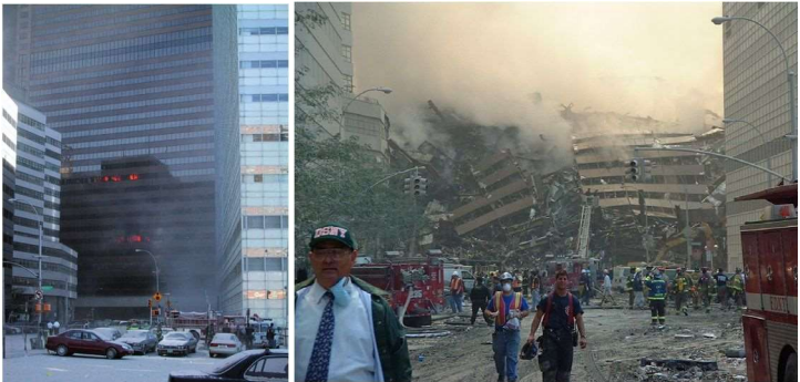
El WTC 7 antes y después de su colapso. Basado en la secuencia de colapso probable del NIST, no habría razón para predecir un colapso total hasta segundos antes de que ocurriera.
