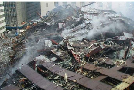
La estructura de acero del WTC 7 se desmembró y depositó en una compacta pila de escombros.
