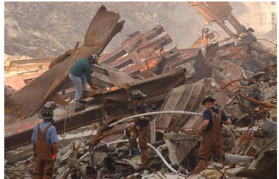
Escombros de estructuras desmembradas del WTC 1 y WTC 2.
