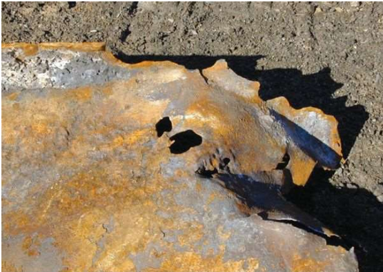
El acero erosionado, sulfatado del WTC 7 en el vertedero de chatarra antes de que fuera cortado y tomado para testear.
