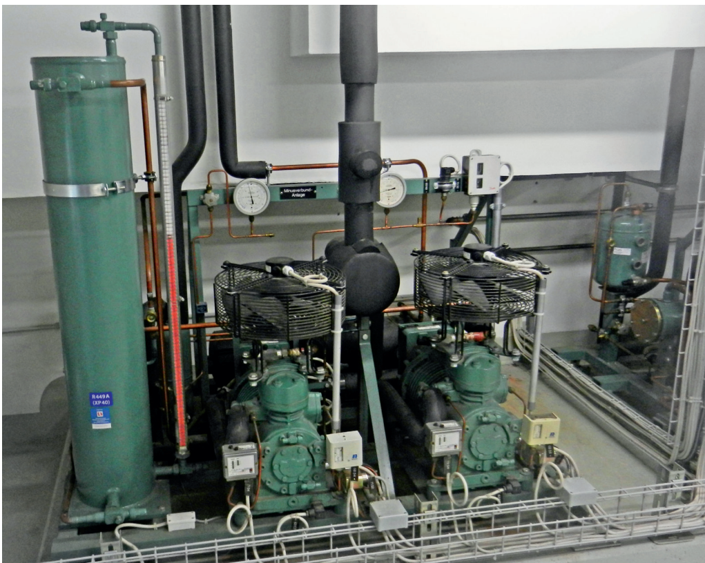
Die Anlage hat einen Tiefkühlkreis sowie einen Pluskühlkreis und wurde bisher mit R404A betrieben. Dank dem Programm der Stiftung KliK konnte die Anlage kostengünstig auf ein umweltfreundliches Kältemittel umgerüstet werden.
