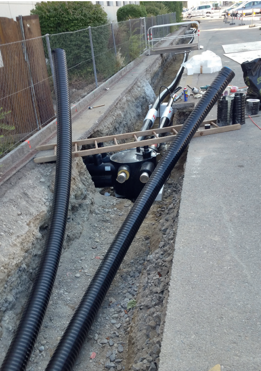
Leitungsbau für die Erweiterung des Wärmeverbundes.
