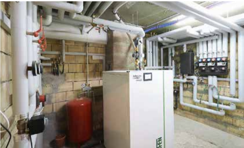
Der neue Pelletkessel mit einer Nennleistung von 25 Kilowatt ersetzt ein altes Pelletaggregat und einen Ölkessel.
