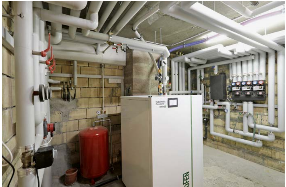
Ein neuer Pelletskessel liefert die Wärme für die drei Wohnungen.
