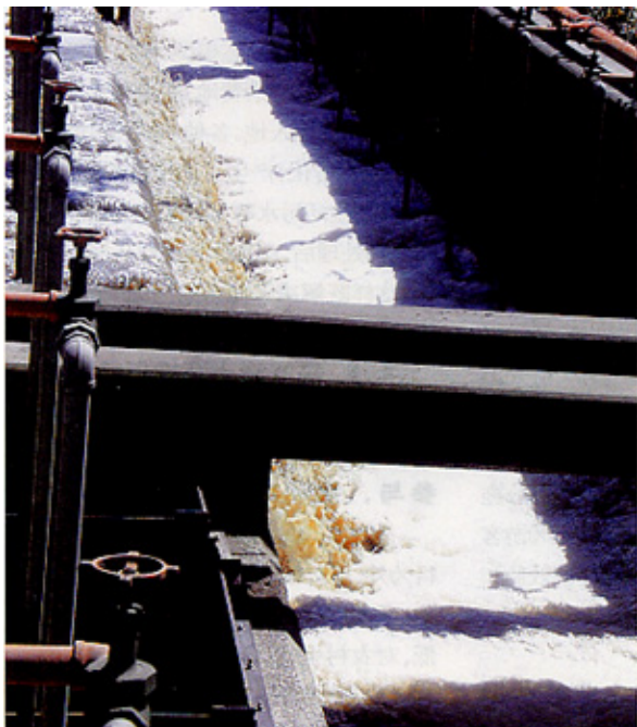
污水处理厂 / 新思维图片
