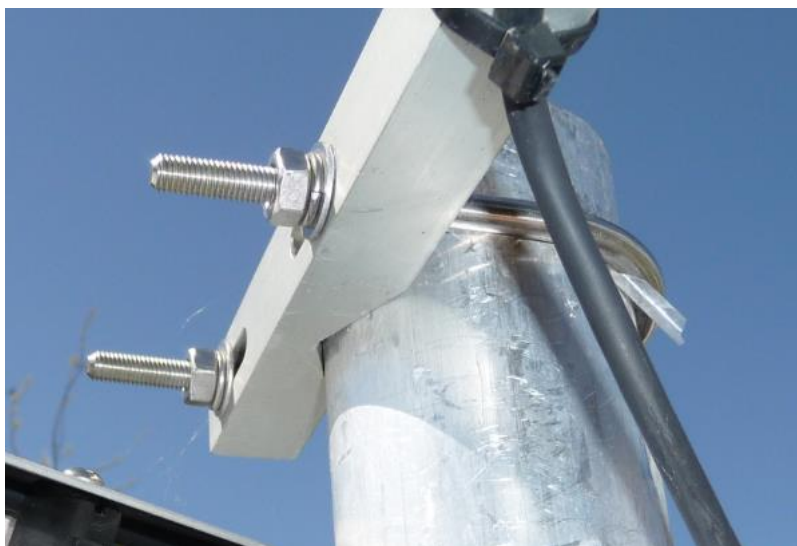
Figura2-2: Montaje del Perno en "U" y el accesorio del brazo de montaje
