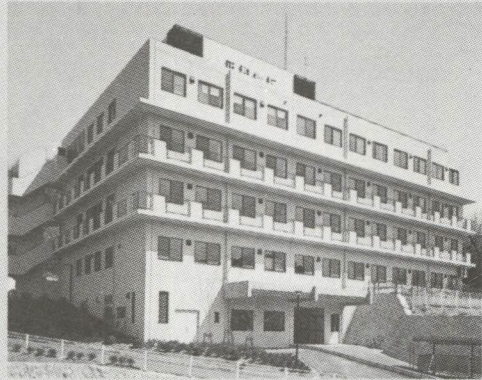
先進のノウハウと、独自の情報ネットワークを活かして企画・設計された、最新設備を誇る総合病院。
