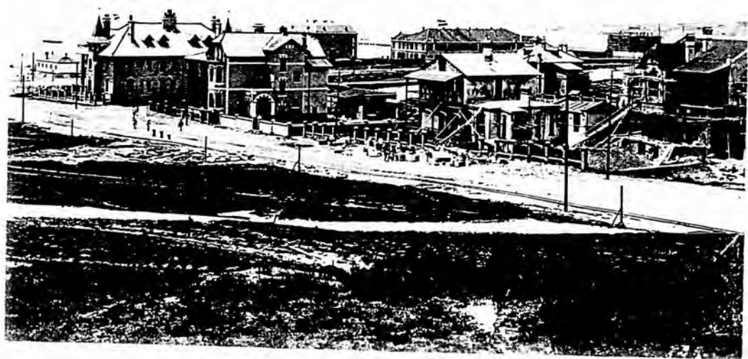
b. Villenbauten an der Bismarckstraße.
