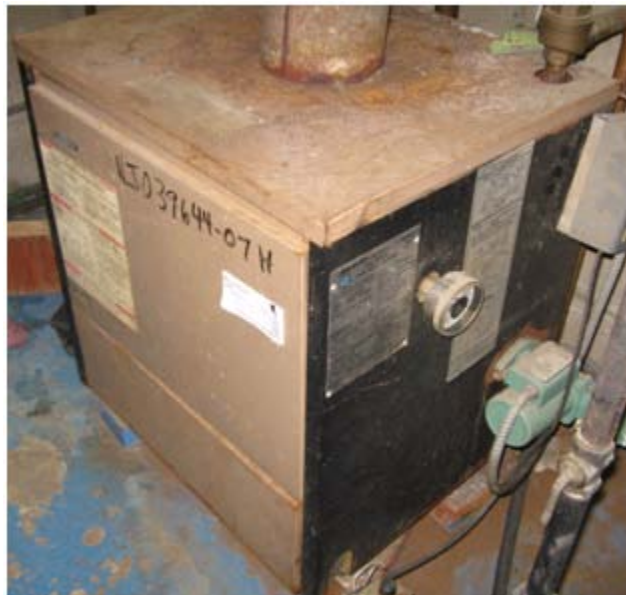
Slant Fin boiler
