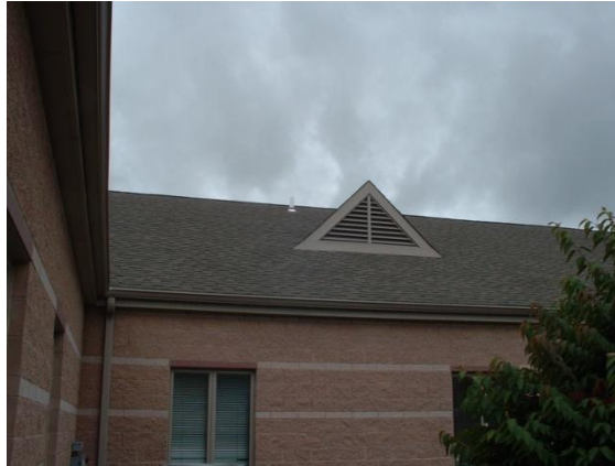
Roof exhaust fan discharge plenum
