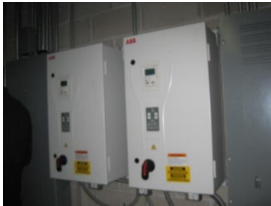
AHU-1 Supply & Return Fan VFD; Manual thermostats
