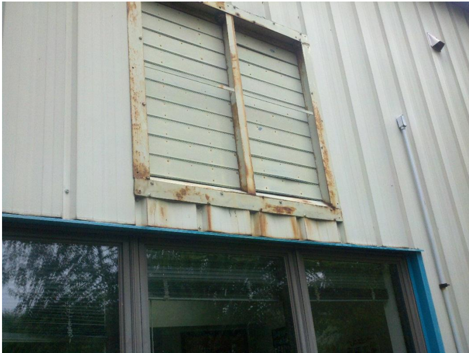
Old Exhaust Fan Louver
