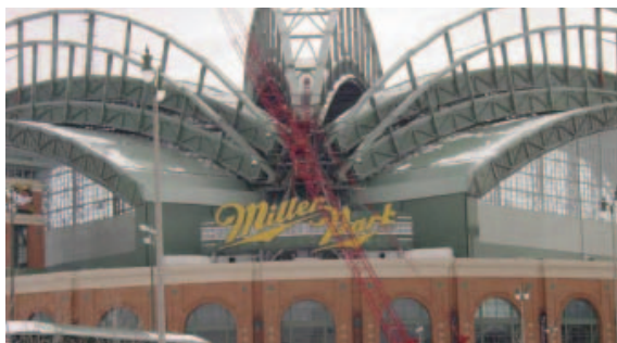
Evaluación del revestimiento e impermeabilización de la cubierta de Miller Park
