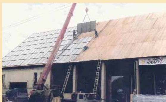
Figura 4: Instalación de captador de gran tamaño
