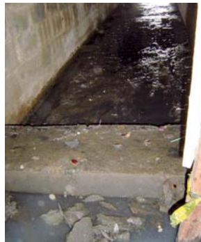
Captações de esgoto em tempo seco, em galeria e em canal superficial, de sistemas de drenagem, em Araruama.
