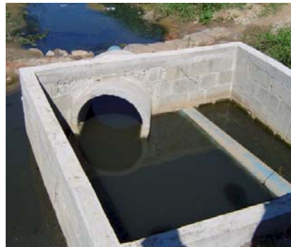
Captações de esgoto em tempo seco, em galeria e em canal superficial, de sistemas de drenagem, em Araruama.
