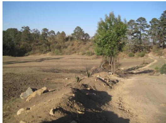
Montículos de tierra de excavación.
