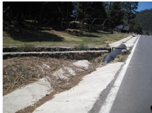
Tubo y cuneta.
