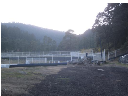
Instalaciones Hidráulicas Monte Alegre
