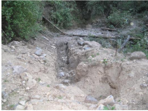
Zanja al lado del río.
