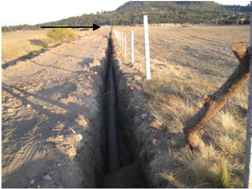
Inicio de obra.
