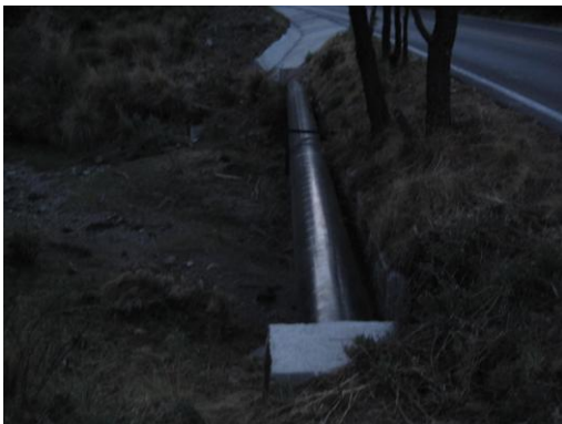
Tobo y cuneta.
