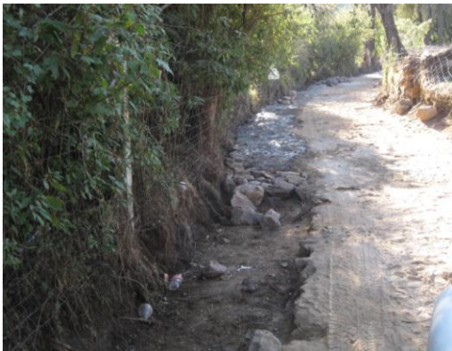
Colocación de piedra pegada.
