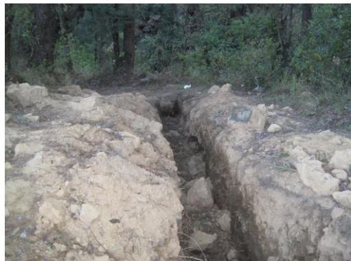
Zanja que llega a un costado del río.
