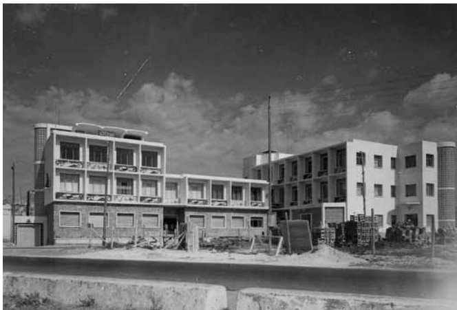
Ambulatorio Hermanos Laulhé en obras. Fuente: Archivo Joaquín Quijano Párraga (San Fernando, Cádiz)
