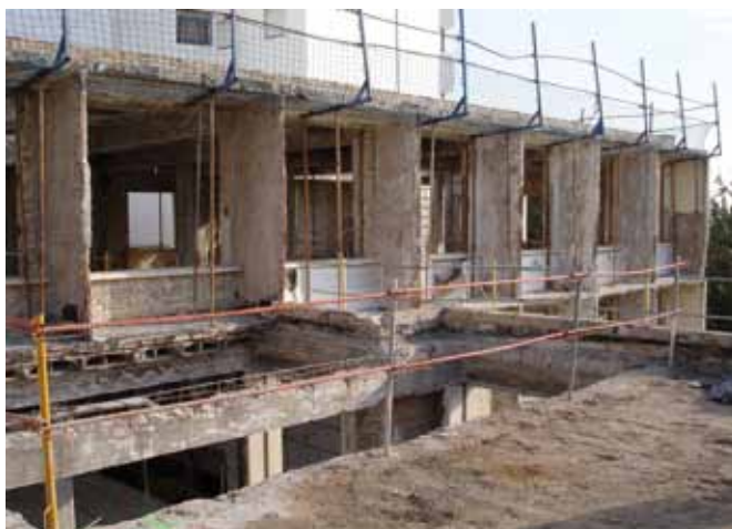
Trabajos sobre la estructura portante
