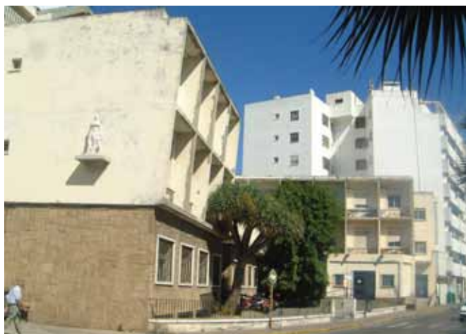
Estado del edificio antes del inicio de las obras en 2006
