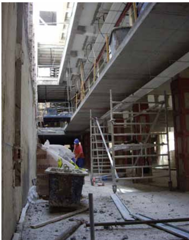
Trabajos sobre el lucernario y apertura de la comunicación con el nivel bajo rasante. Fotos: Ignacio Laguille
