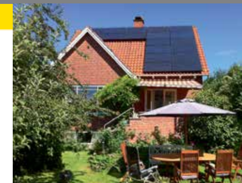
Villaens solcelleanlæg ligger på et vestvendt tag, der giver en udnyttelsesgrad på 75 procent.
